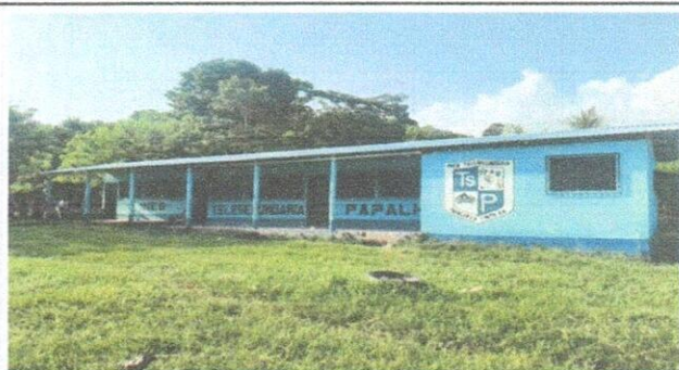
Foto1: Se colocaron láminas troqueladas.
