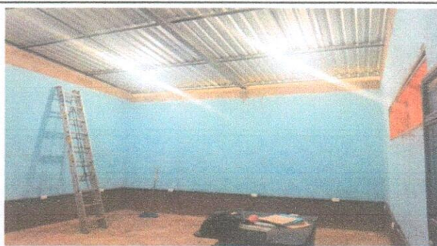
Foto 2: se instaló el sistema eléctrico en el laboratorio de Computación, en las aulas y en la Dirección.
