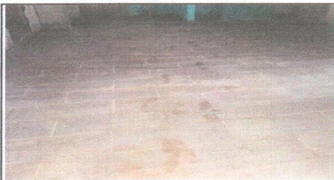
Foto 3: Se colocó piso cerámico
